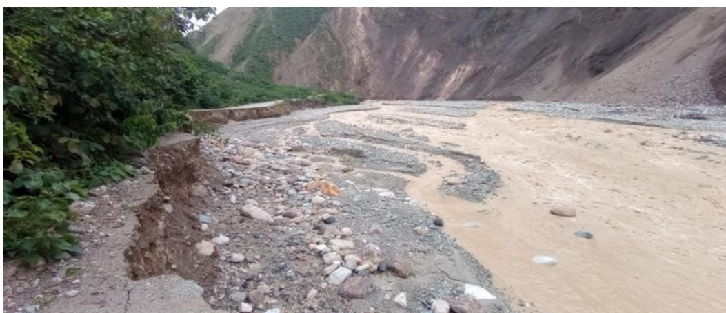
FIGURA N°02: EN EL RECORRIDO SE OBSERVA QUE EL RIO, EN SU MARGEN DERECHA VIENE AFECTADO PARTE DE LA CARRETERA TOTALMENTE DESTRUIDA
