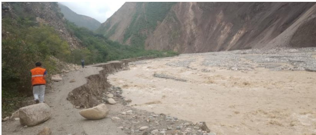
FIGURA N°01: RECORRIDO E IDENTIFICACION DE TRAMOS CRÍTICOS DESDE EL PUNTO DE INICIO, DONDE SE PUEDE VISUALIZAR QUE EL RIO EN SU MARGEN DERECHA AFECTADO A VIVIENDAS Y PARTE DE LA CARRETERA DESTRUIDA.
